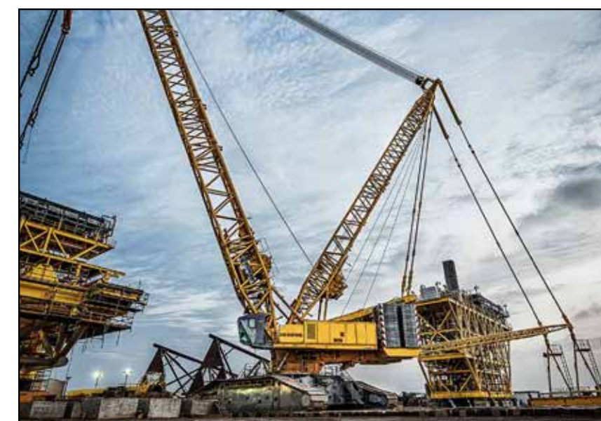
Gruas de Rasto LR Crawler Cranes
